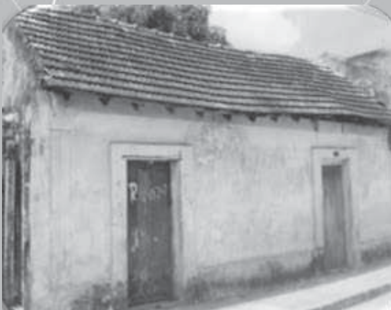
Casa de Kica Suarez Romero. Construida por Benito Ditta en 1937, ubicada en la antigua calle Santa Bárbara, luego calle del medio, hoy calle 5a.
