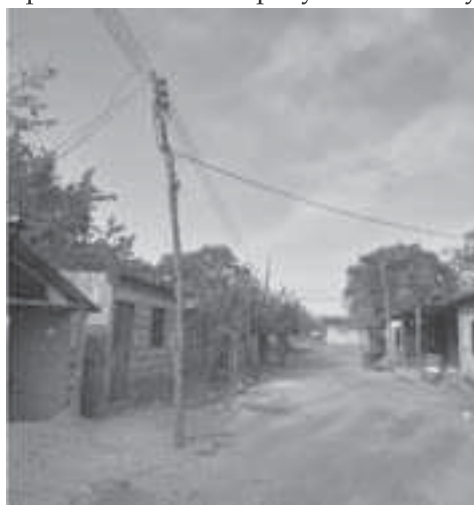
Vista parcial de una calle en Boquerón, denota el abandono estatal. Fuente El Pilón.
